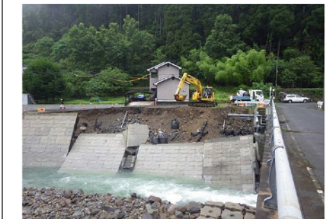
豪雨被害を受けた日田市小野地区。現場調査の後、いち早く大型土嚢の設置に取り掛かる
