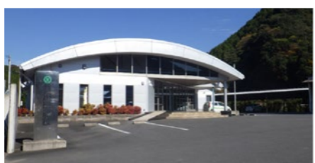
創業1964年。山国川沿いに社屋を構え、長年地域や県内の土木・河川工事を担っている
