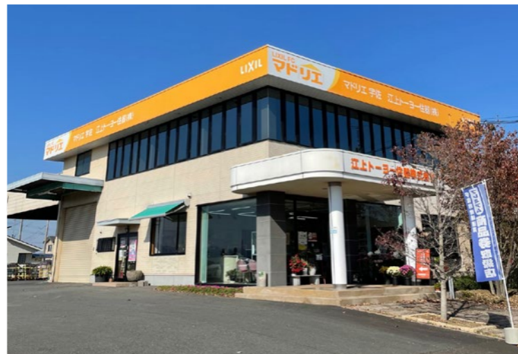
新築住宅の外構工事ももちろん、ガーデンリフォームも行う
