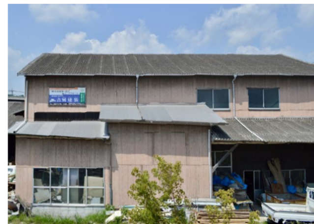
基礎工事や解体工事も自社で行う。さらに吉岡康二代表は、大工技術を活かした木彫り作品の制作にも熱心に取り組む
