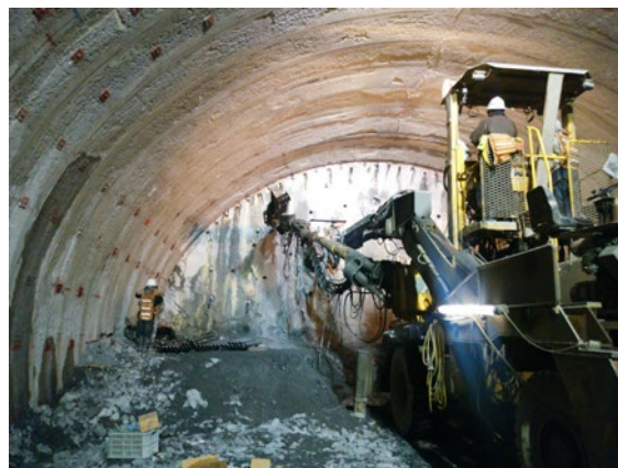
現在建設中のトンネルの現場。人が重機と接触する危険区域に入るとセンサーが知らせる
