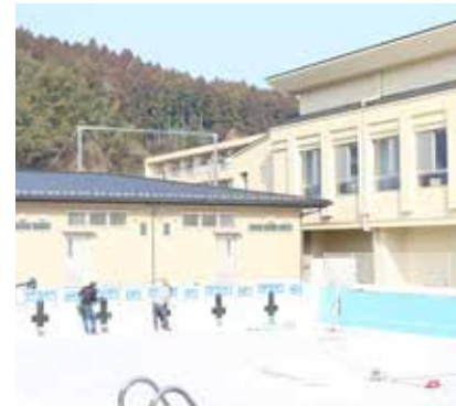
改修工事に携わった「くす星翔中学校」の現場。この春、長男が入学するため作業にいつそ力が込められた
