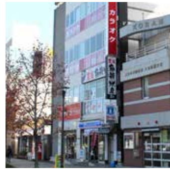
人通りの多い大分駅前にある「南光汽船ビル」は人気のカフェ「居酒屋」などの入居テナントビル
