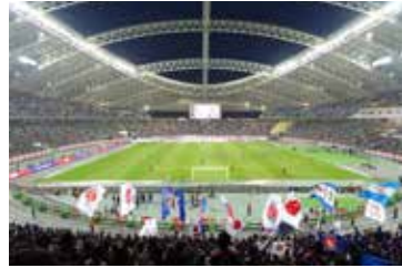
大分銀行ドームの照明は4K、8K放送にも対応できるように改修。その技術力の高さを世界に知らしめた
