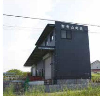
大在に新しく建設した倉庫兼工房
