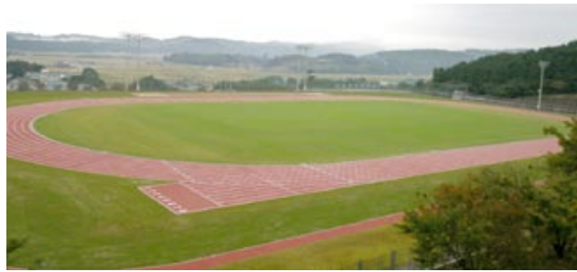
久保組が施工した「総合運動公園（多目的広場）」
