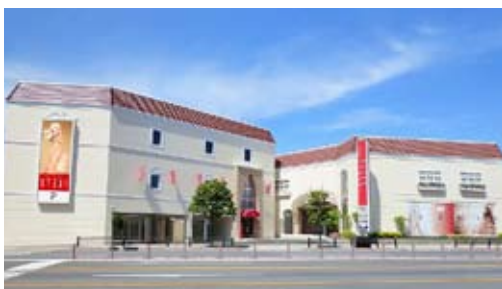
道路沿いに優雅に佇むエヴァーズ社屋。写真スタジオ「ラブ」も隣接
