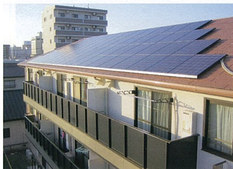
屋根に太陽光発電を設置した集合住宅
